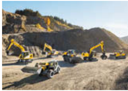
Maszyny do robót ziemnych
